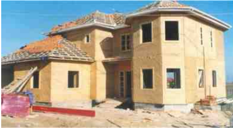
Pose de la couverture du toit
