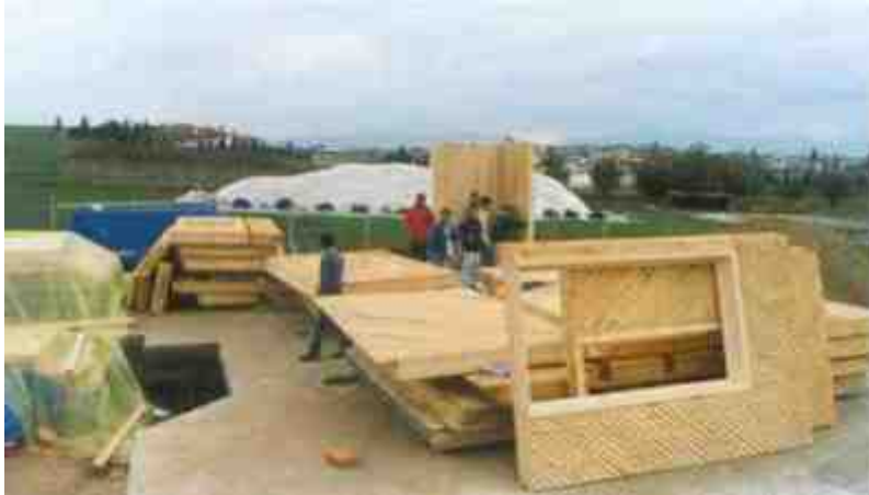
Arrivée de l'ossature sur le chantier. Les murs arrivent sous forme de panneaux qui seront assemblés sur le chantier.
