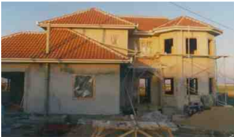
Pose de la couverture du toit
