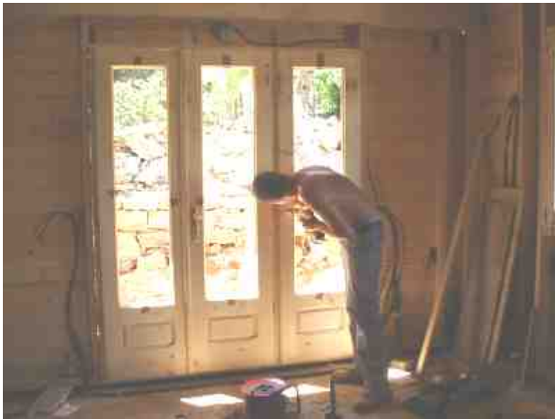
Placement de la menuiserie
