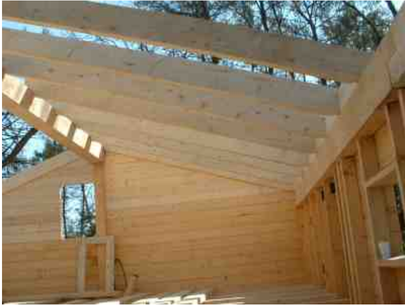
Placement de la charpente
