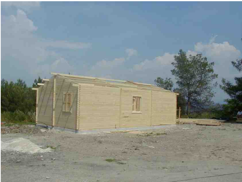
On pose la charpente sur les murs.
