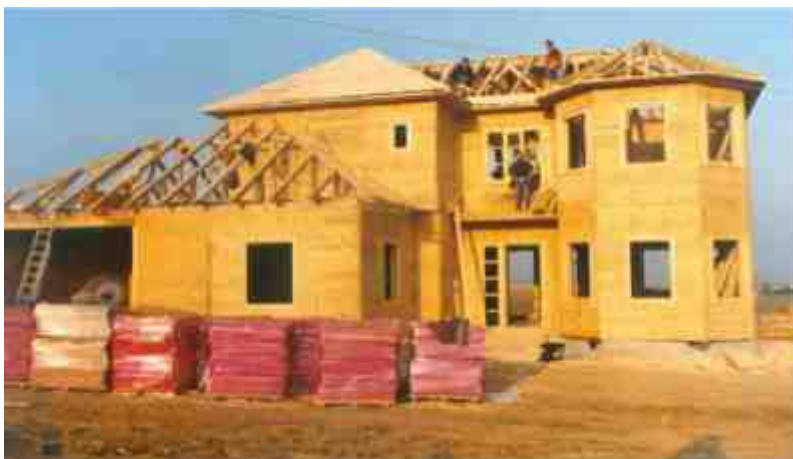
Montage de l'étage et de la charpente
