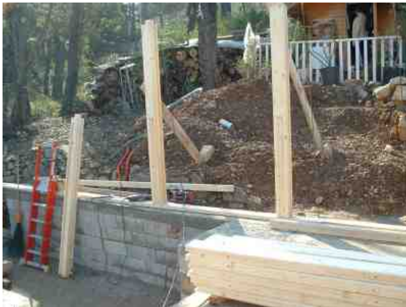
Positionnement des poteaux
