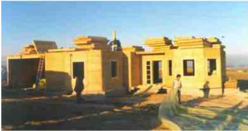
Montage du rez de chaussée. Les panneaux comportent déjà l'ouverture pour les menuiseries.
